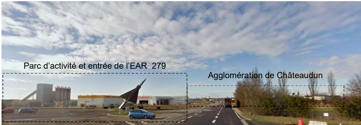
Figure 68 : vue du parc d'activité de la route d'Orléans marquant l'entrée de l'agglomération de Châteaudun (D 955) au niveau de l'entrée principale de l'EAR 279 (à gauche)
